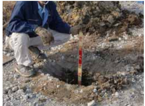
予定杭長まで掘削。 直径は40cm
