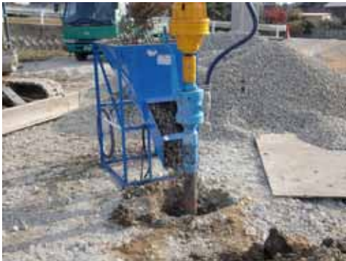
砕石を投入し、周辺圧密をしながら 砕石杭を構築。
