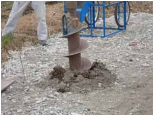
設計データによる位置へ杭芯をセット
